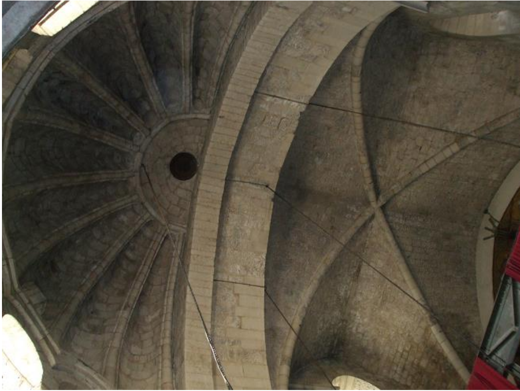
Fig. 5. Abside: vista interna verso l'alto
