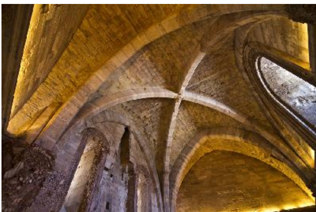
Fig. 1.4.4. Archi diagonali in una volta a crociera
