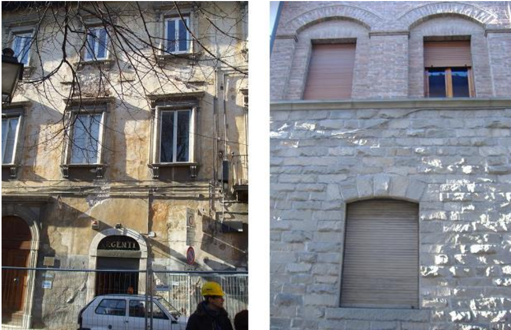
Fig. 1.4.3. Pareti murarie in elevazione che insistono su archi sottostanti
