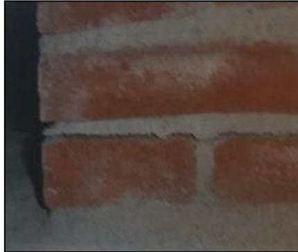
Figura 127. Distacco tra malta e laterizio per effetto della trazione [3]
