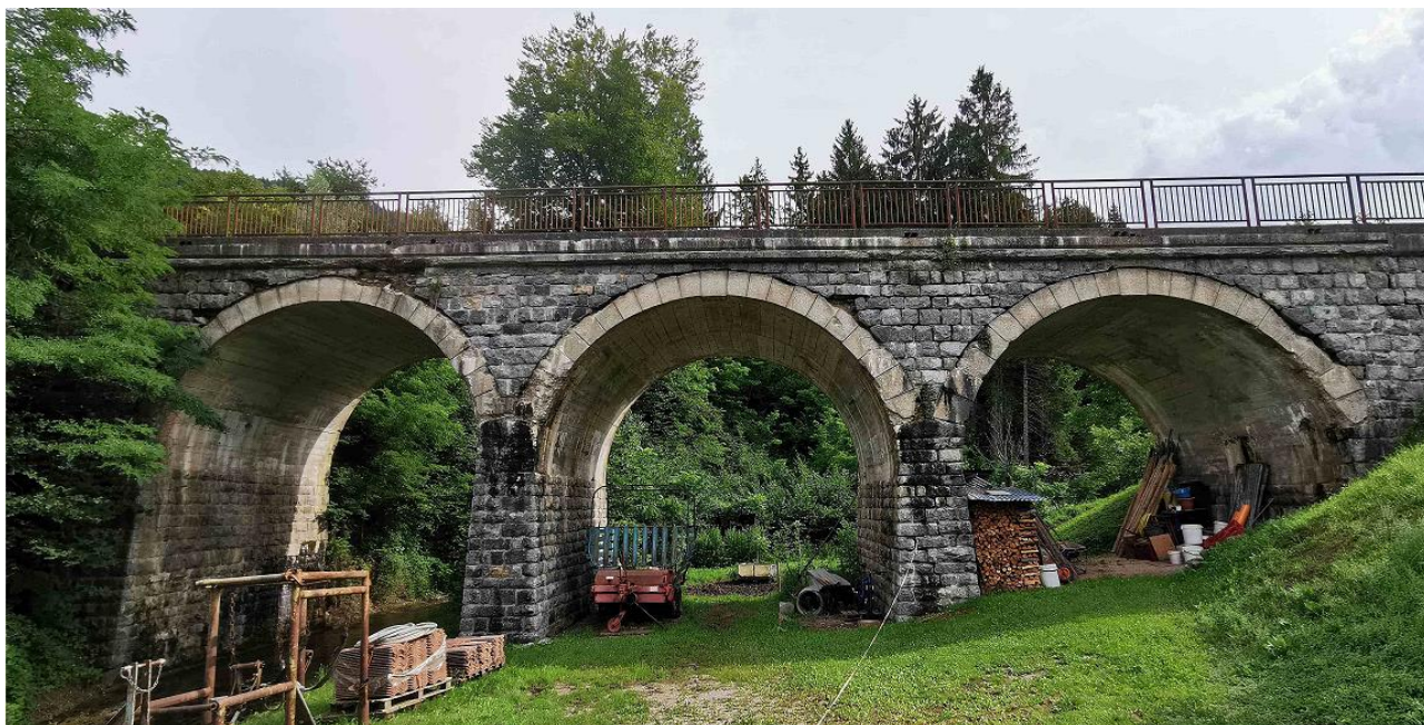
Fig. 2.30. Esempio di ponte stradale multicampata
