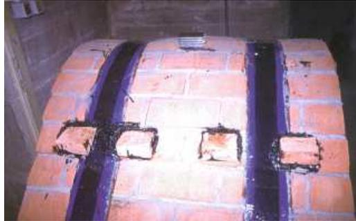
**Fig. 3.3.6.** Volta muraria con applicazione di compositi fibrorinforzati
