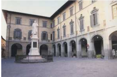
Fig. 4.4.1. Portico di un palazzo storico
