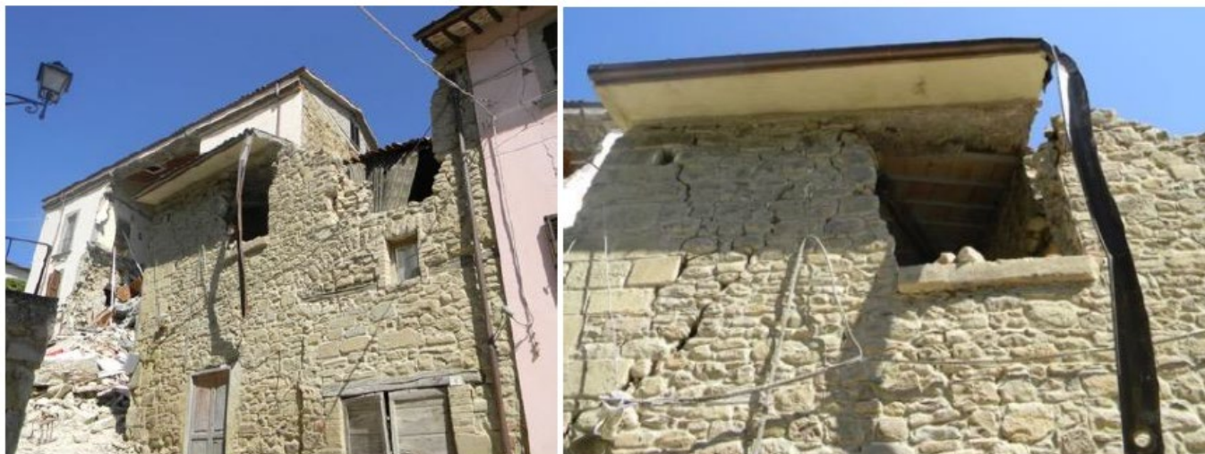
Fig. 10. Disgregazione di un edificio in muratura (da [3])
