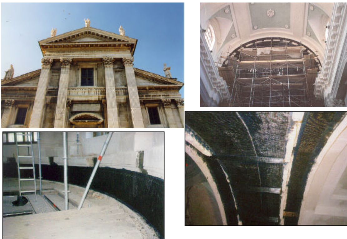
Figure 9 . 10 . 11 . 12– Duomo di Urbino - Urbino – Fornitura di fibre di carbonio compreso il trasferimento tecnologico con consulenza specialistica al personale tecnico ed operativo per il lavoro di consolidamento e miglioramento sismico della Cattedrale di Urbino (intervento sul tamburo della cupola, sul transetto, l'abside e le travi di collegamento lignee della navata principale).
