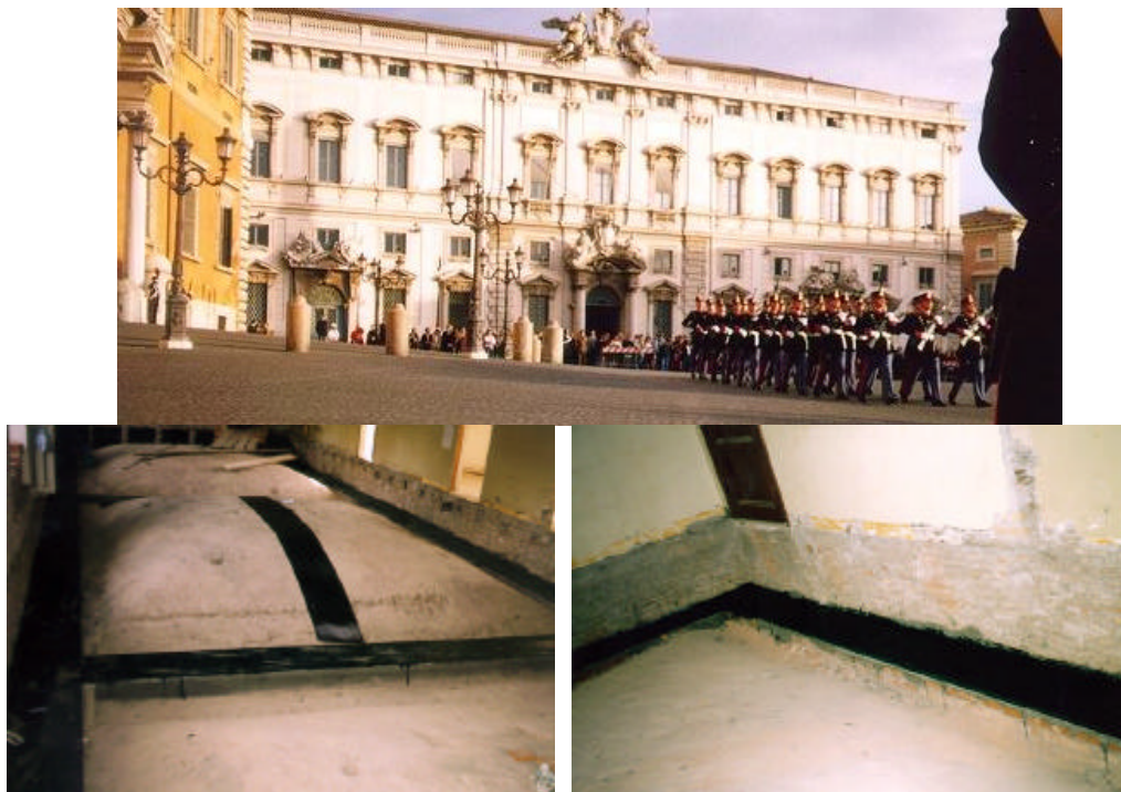
Fig. 6 – 7 – 8 – Palazzo della Consulta - Roma - Rinforzo della zona d'imposta delle volte mediante la realizzazione di un cordolo di fibre di carbonio.
