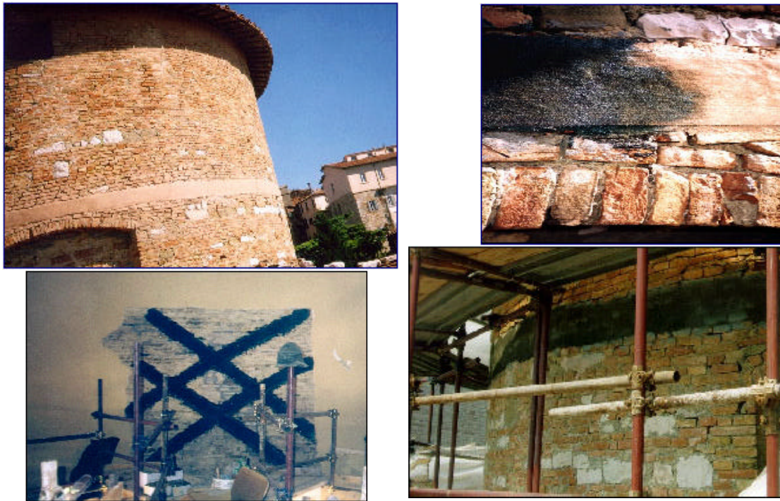
Fig. 19 – 20 – 21 – 22 - Chiesa Santa Teresa - Perugia - Presidio degli stati fessurativi dell'intradosso dell'abside mediante intersezione di fogli di fibra incrociati secondo due direzioni principali. Cerchiatura su due livelli con fibre di carbonio del tamburo dell'abside a livello di copertura e di imposta della cupola sottostante.
