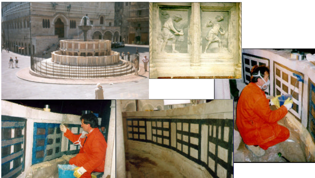
Fig. 13 – 14 – 15 – 16 – 17 – 18 – Fontana Maggiore - Perugia - Rinforzo, confinamento e collegamento tramite FRP delle formelle di marmo realizzato all'interno del bacino inferiore della Fontana Maggiore di Perugia (XIII sec.). Nel caso specifico l'intervento è consistito nell'applicazione controllata di nastri di fibre di vetro con preventiva fase di rilievo dello stato fessurativo delle formelle anche con metodi non distruttivi, e relativa schedatura ed informatizzazione.
