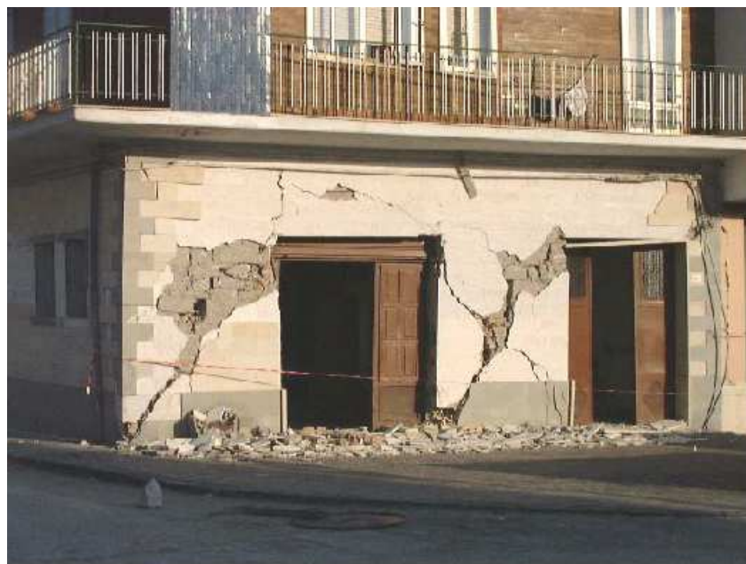
Fig. 1.1.2. Rotture a Taglio per fessurazione diagonale [2]
