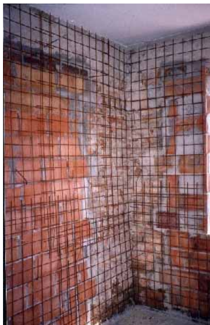
Fig. 84. Applicazione di intonaco armato.
