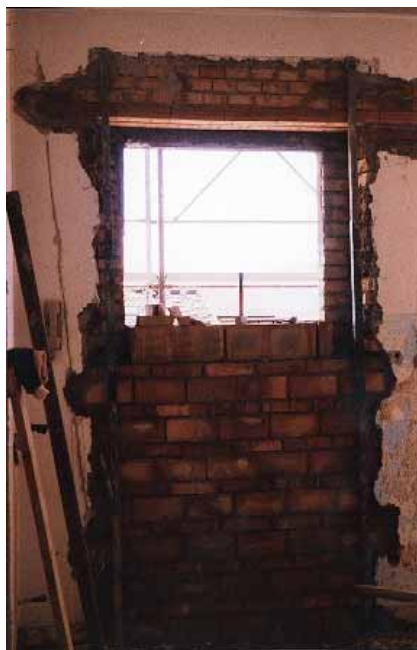
Fig. 85. Chiusura di apertura e tamponamenti di sottofinestra.
