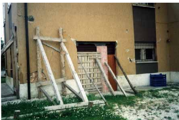
Fig. 78. Lesione vicina allo spigolo del fabbricato.
