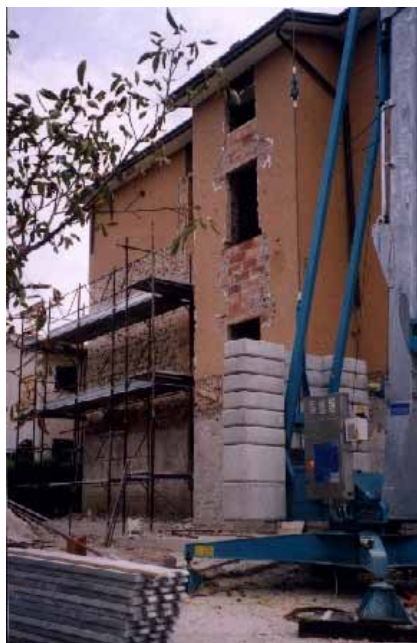
Fig. 86. Tamponamenti e architravature ai piani superiori.
