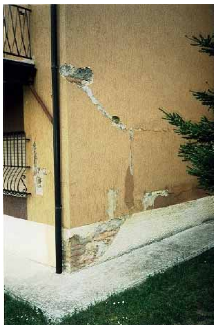
Fig. 80. Altra lesione vicino allo spigolo.
