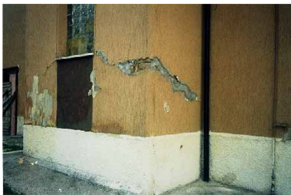
Fig. 79. Lesione in zona scale.
