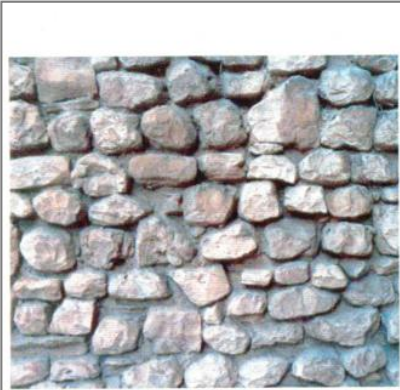
Fig. 1 - Muratura in pietraforte fortemente degradata per erosione e decoesione dei giunti di malta. Il degrado avanzato delle malte può provocare il distacco dei blocchi lapidei con instabilizzazione e caduta degli stessi.
