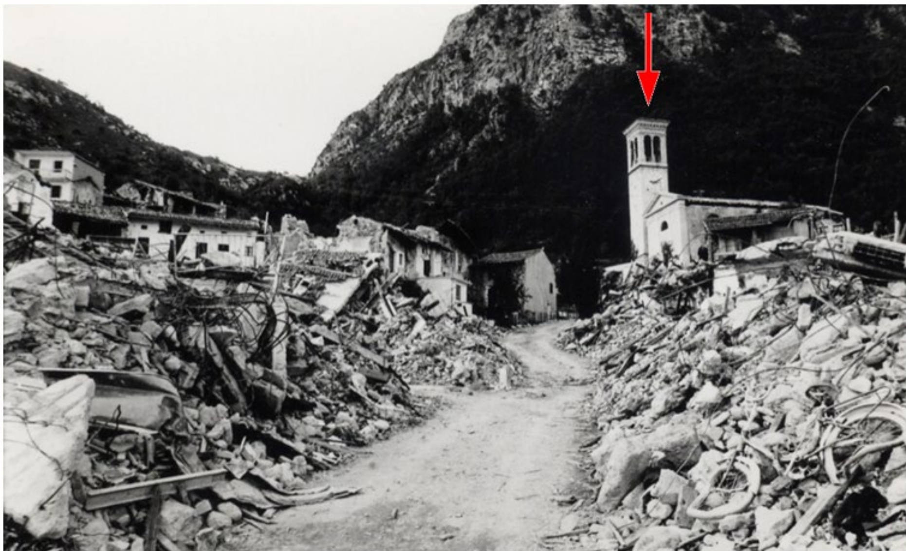
Danni sismici in Friuli (2016). In evidenza, un campanile non interessato dai fenomeni disgregativi
