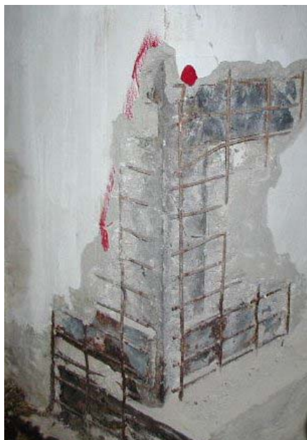
Fig. 6.32 Particolare intervento con calastrelli alla base del pilastro
