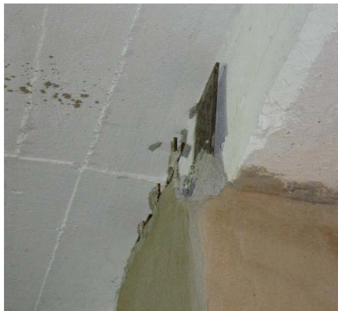
Fig.6.33 Particolare intervento all'attacco con la trave (attesa ripresa rinforzo)
