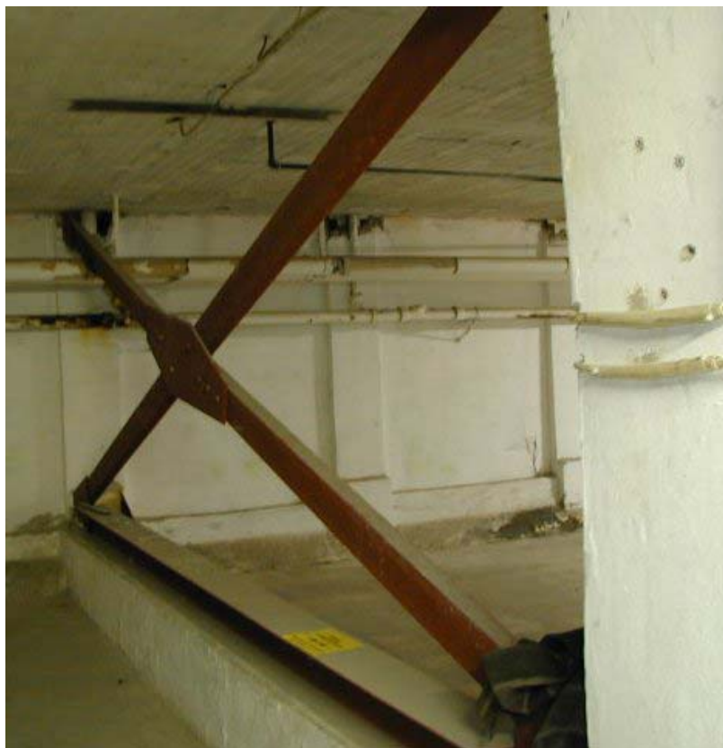
Fig.6.31 Particolare struttura di controvento
