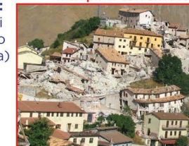
...dopo il terremoto
