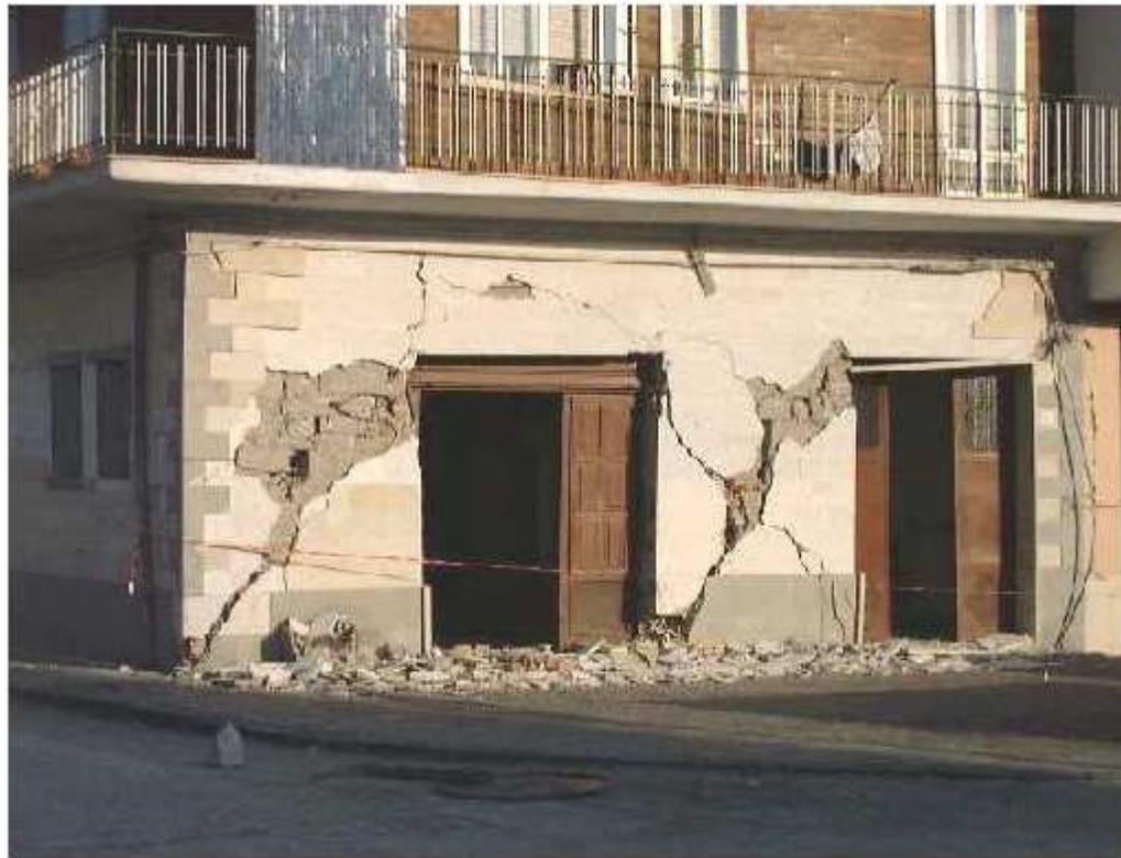
**Fig. 2.** *Rotture a Taglio per fessurazione diagonale [2].*
