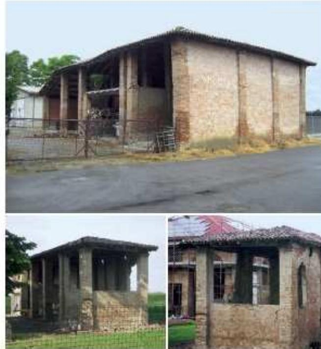
Questa tipologia consiste in genere in una struttura monopiano, con copertura sostenuta principalmente da pilastri murari, ed eventuali murature perimetrali, talvolta di puro tamponamento (casi molto presenti in Emilia). I **pilastri murari** sono gli elementi strutturali fondamentali: lo studio deve essere condotto con modelli appropriati
