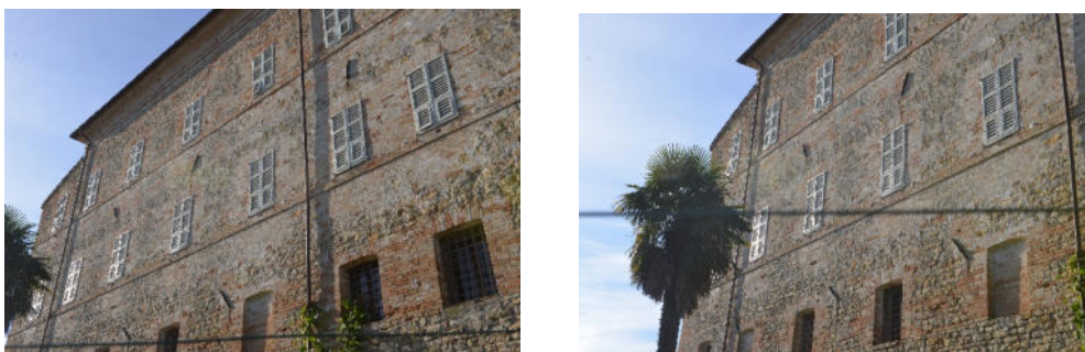
Figura 30. Edificio del Monastero che si affaccia sull'orto
