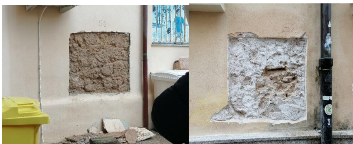
Figura 31. Saggi sulla muratura lato cortile e lato strada via Carlo Alberto.
