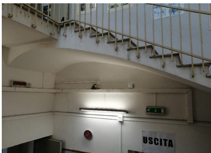
Figura 11. Particolare architettonico della scala.
