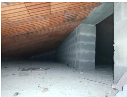
Figura 35. Muratura di spina del sottotetto.
