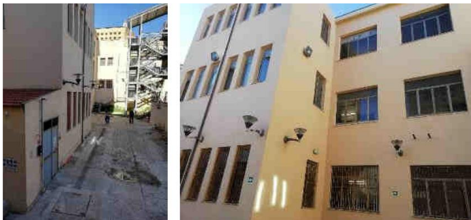
Figura 7. Vista dell'edificio dalla corte interna.
