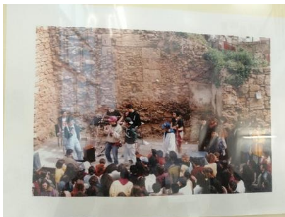
Figura 32. Foto storica per la ricostruzione della composizione muraria.
