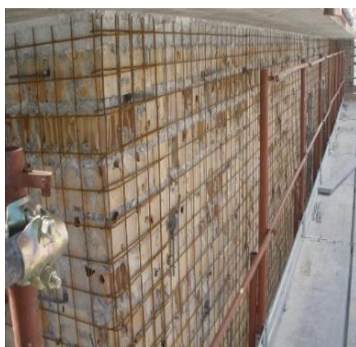
Figura 143. Immagine descrittiva della tecnica di rinforzo con intonaco armato.
