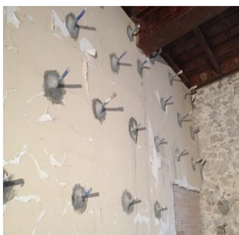
Figura 147. Immagine descrittiva della tecnica di rinforzo con iniezioni di malta.
