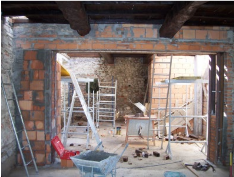
Fig. 9.1. Cerchiatura con telaio in acciaio di grandi dimensioni
