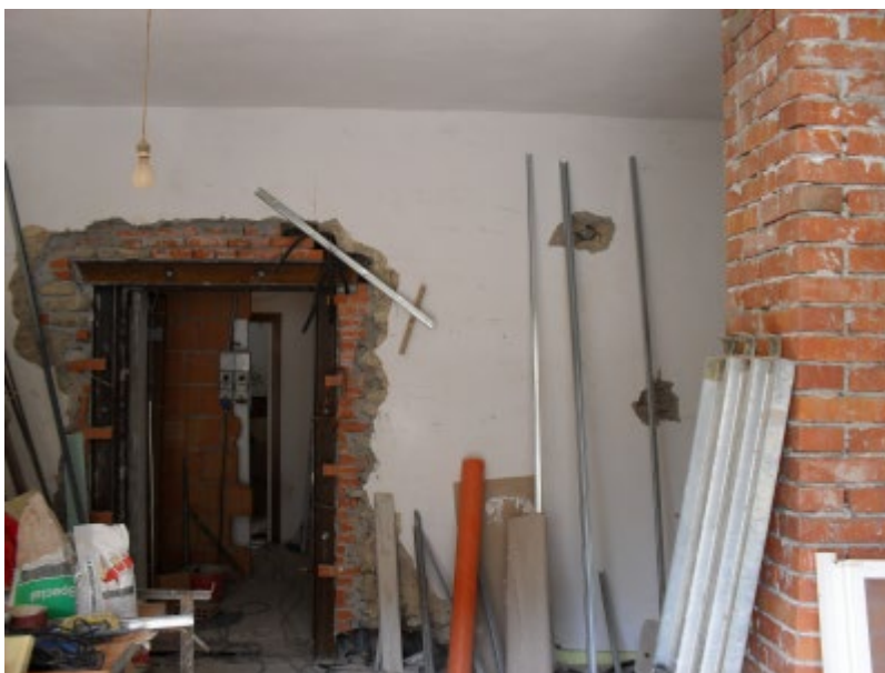
Fig. 9.2. Intervento per nuova apertura in muro di mattoni pieni
