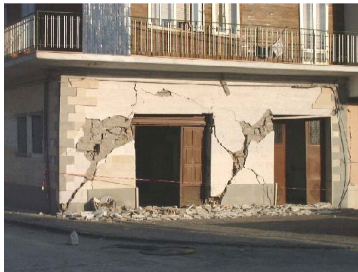
Fig. 4.3. Rotture a Taglio per fessurazione diagonale [9]
